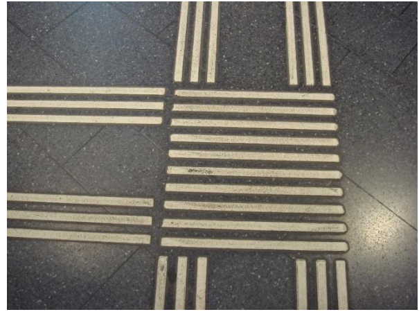
図 4. JIS 規格とは異なる形状の警告用のブロック 3 (チューリッヒ・スイス)
