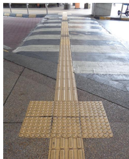
図 11. 誘導用のブロックと同じ形状のブロックを 使用したエスコートゾーン (クアラルンプール・マ レーシア)
