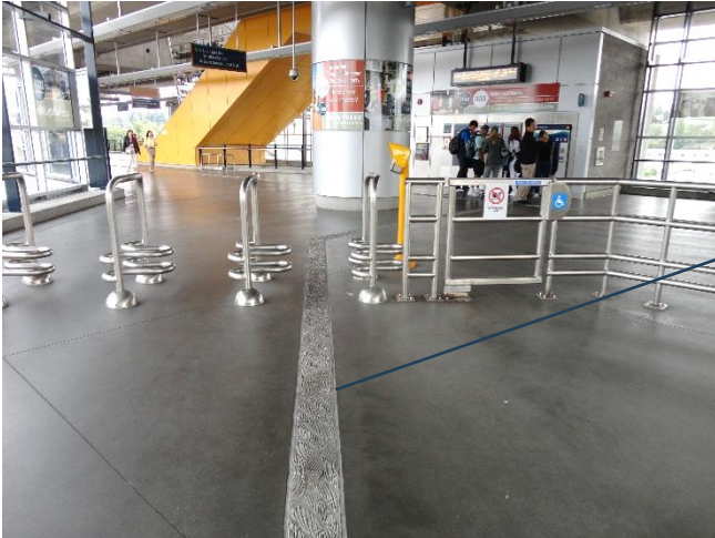
図 7. JIS 規格とは異なる形状の誘導用のブロック 2 (シアトル・USA)
