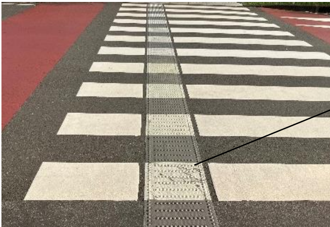
図 9. エスコートゾーンのための独自の形状のブロック 1 (宮崎・日本)
