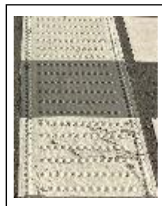
図 8. JIS 規格とは異なる形状の誘導用のブロック 3 (コペンハーゲン・デンマーク)
