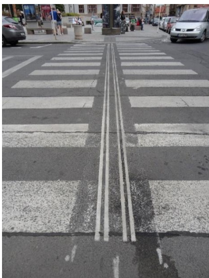
図 10. エスコートゾーンのための独自の形状のブロック 2 (ウィーン・オーストリア)
