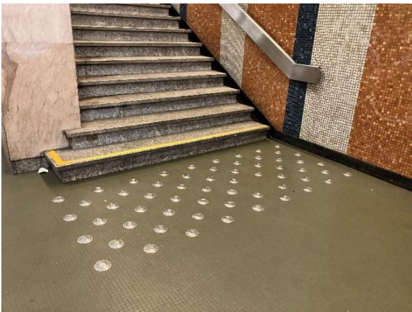
図 2. JIS 規格とは異なる形状の警告用のブロック 1（ブリュッセル・ベルギー）
