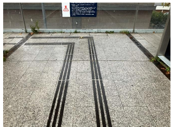
図 6. JIS 規格とは異なる形状の誘導用のブロック 1（パリ・フランス）
