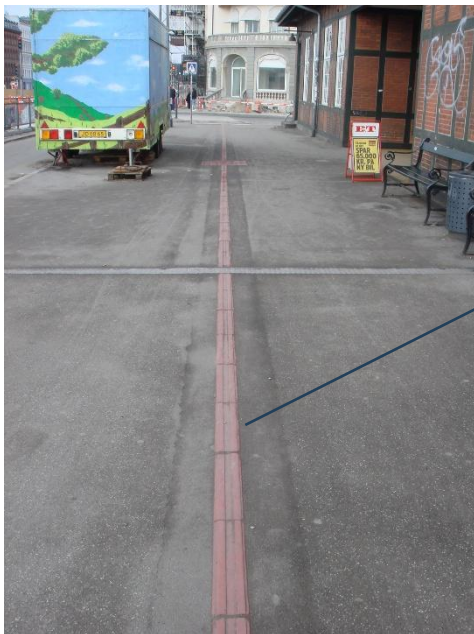
図 8. JIS 規格とは異なる形状の誘導用のブロック 3 (コペンハーゲン・デンマーク)
