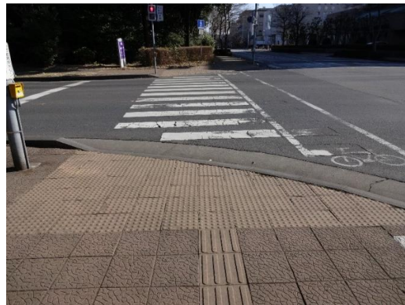
写真 13. 横断歩道前に必要以上の警告ブロックが設置されている(筑波大学前)
