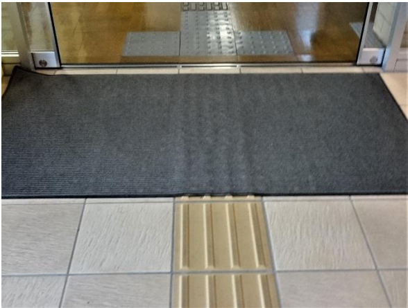
写真 28. 建物の入り口の点字ブロックのうえに足ふきマットがおかれている箇所(つくば市内)
