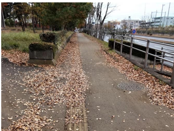
写真 24. ブロックの上に落ち葉が覆いかぶさっており、滑る危険がある箇所(つくば市内)
