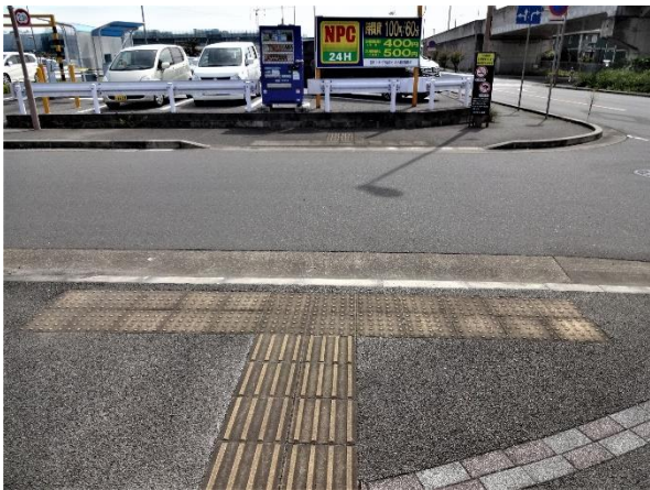
写真 17. 横断歩道のない場所に設置されている横断歩道前の点字ブロック 1 (みどりの駅前)
