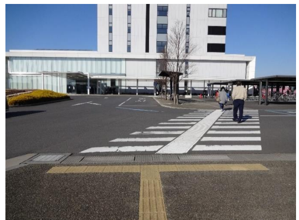
写真 9. 横断歩道前の誘導ブロックが横断歩道の進行方向と平行になっていない 2 (つくば市役所)
