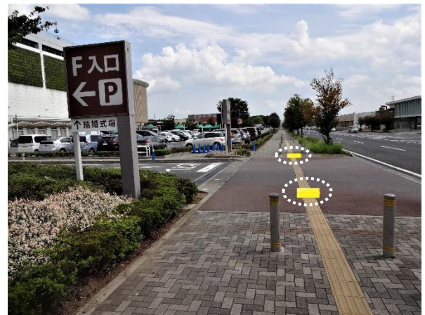
写真 2. 写真 1 のケースの修正案として駐車場入口に警告ブロック (白の点線の箇所) を設置する
