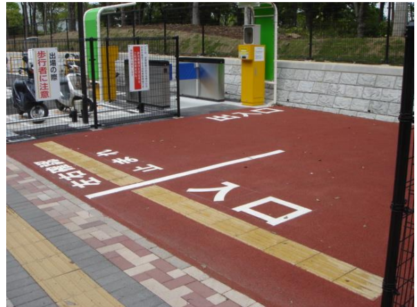
写真 29. 黄色の誘導ブロックを駐輪場の停止線として目的外使用している箇所(つくば駅周辺)
