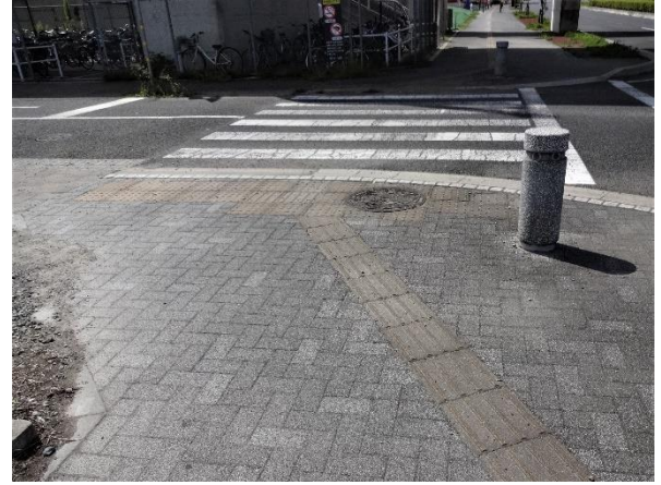
写真 7. 横断歩道前の誘導ブロックが横断歩道の進行方向と平行になっていない 1 (万博記念公園駅周辺)
