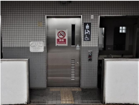
写真 16. 多目的トイレの入り口の全幅いっばいに警告ブロックが設置されている(つくば駅周辺)
