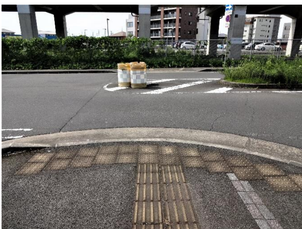
写真 18. 横断歩道のない場所に設置されている横断歩道前の点字ブロック 2 (みどりの駅前)
