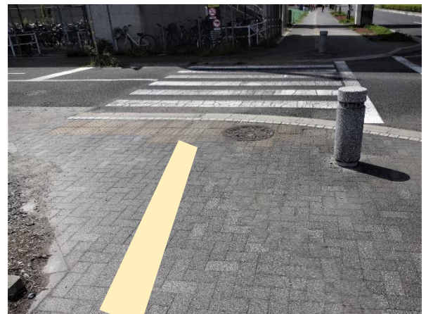
写真 8. 写真 7 のケースの修正案：誘導ブロックの線状突起を横断歩道の進行方向と平行にする
