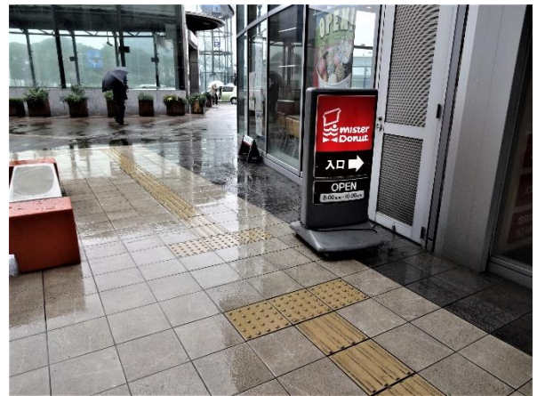
写真 14. 2 箇所に警告ブロックが設置されているが、この位置で立ち止まる必要がない 1(つくば駅周辺)
