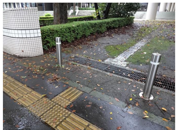
写真 3. 歩道の誘導ブロックと施設内の誘導ブロックが接続していない (筑波技術大学前)
