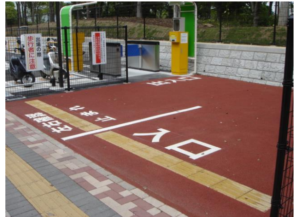
写真 29. 黄色の誘導ブロックを駐輪場の停止線として目的外使用している箇所(つくば駅周辺)
