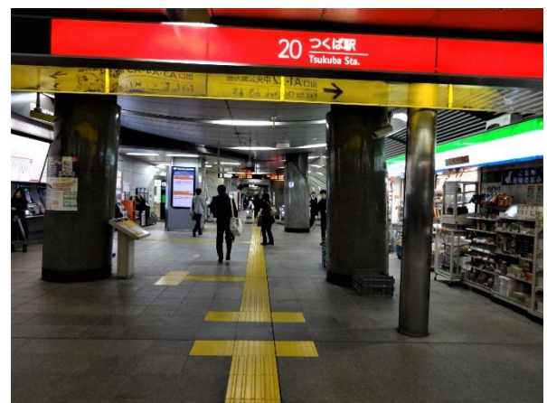
写真 15. 2 箇所に警告ブロックが設置されているが、この位置で立ち止まる必要がない 2(つくば駅構内)
