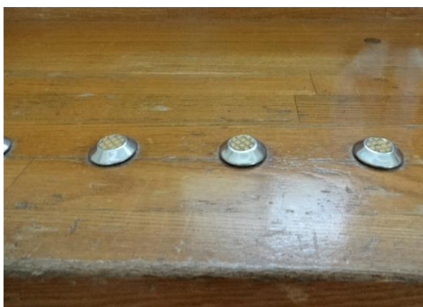
写真 3. B 保育園に設置されている金属鉾
