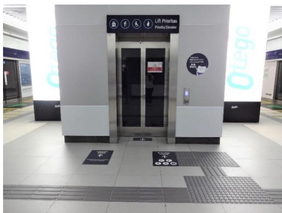
写真 17. エレベータ前の点字ブロック
