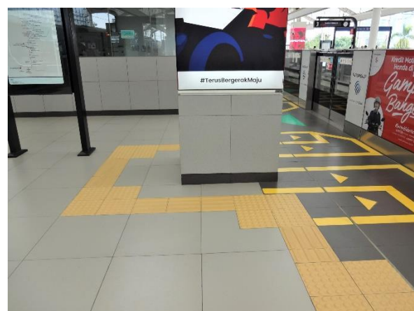
写真4. 柱を避けるために複雑な設置の仕方になっている
