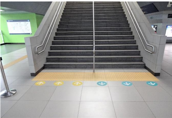
写真 23. 階段前の点字ブロック
