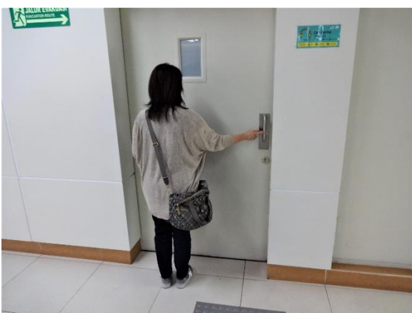
写真 28. ドアノブの位置が高い多目的トイレ
