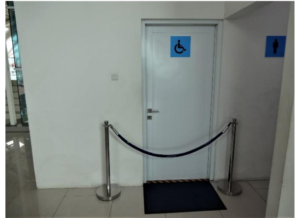
写真 29. 開き戸の多目的トイレ
