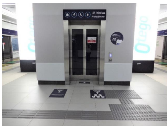
写真 17. エレベータ前の点字ブロック
