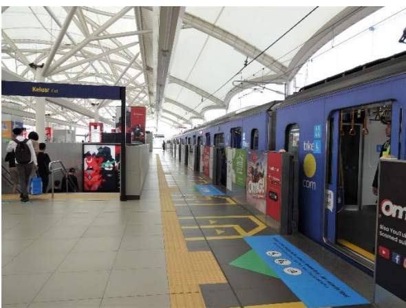
写真2. 黄色のブロックが設置されている駅
