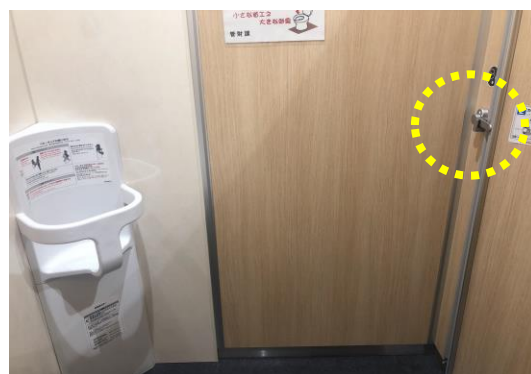
写真 11. 子どもが操作しやすい高さの1か所のみを設置された鍵（つくば市役所コミュニティ棟）
