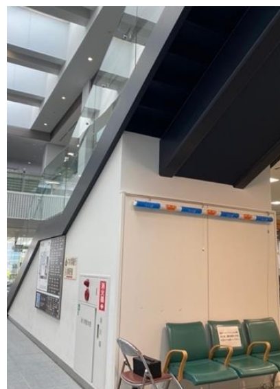
写真 21. 階段下に入れない設計がされている (つくば市役所)
