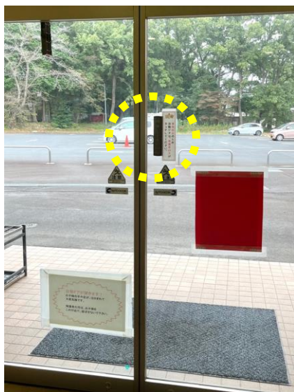
写真2. 子どもの手の届かない位置に開閉ボタンが設置されている(つくば市子育て支援センター)
