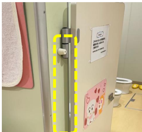
写真 10. ドアの中に隙間が設けられている（つくば市子育て支援センター）
