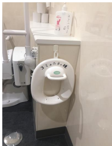
写真 5. 子ども用補助便座が設置されている (つくば市役所コミュニティ棟)
