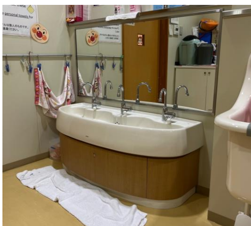
写真 8. 子どもが使用しやすい高さの洗面台（つくば市子育て支援センター）
