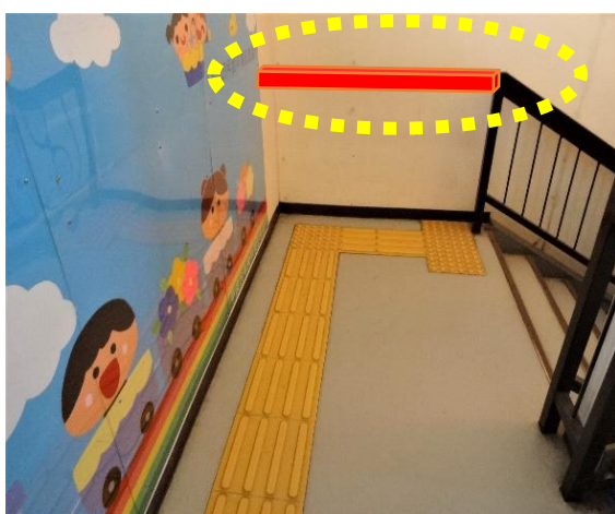
写真 5. 踊り場の階段の手すりのつけ方
