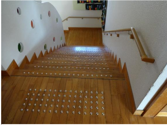
写真 2. B 保育園の階段の点字ブロック
