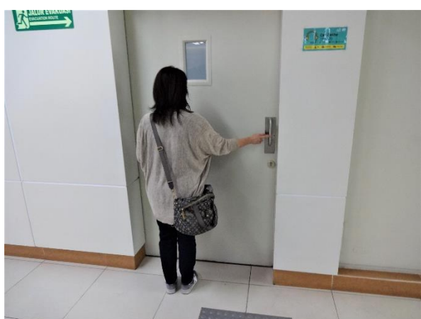
写真 28. ドアノブの位置が高い多目的トイレ
