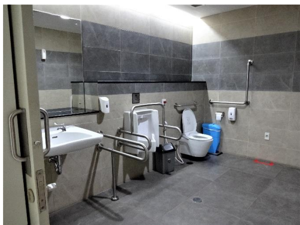
写真 26. 多目的トイレの中の手すり付き男子用小便器
