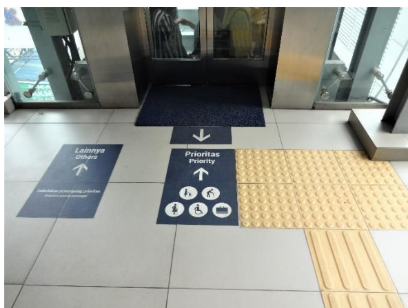
写真 18. プライオリティレーンの不適切位置
