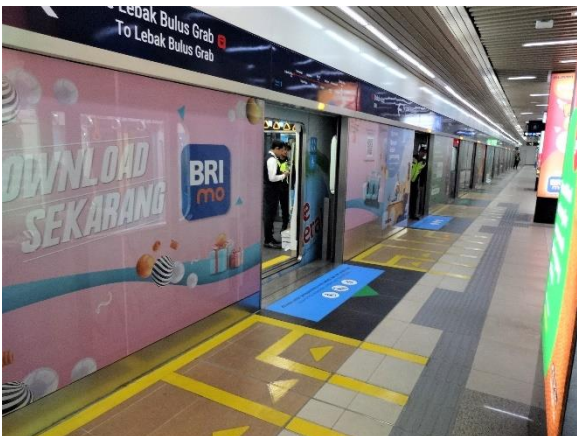
写真1. 灰色の点字ブロックが設置されているプラットフォーム
